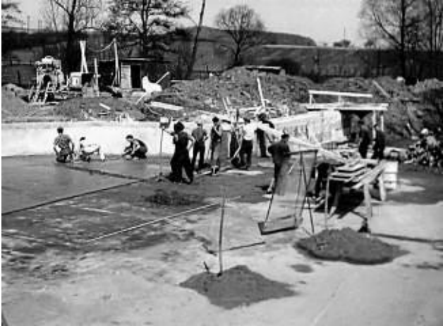
Eigenleistung: Zahlreiche Obervellmarer Bürger halfen 1954 mit ehrenamtlichen Arbeitseinsätzen beim Bau des Schwimmbades. Neben dem Ausheben der gesamten Baugrube, wurde gefliest, gestrichen oder es wurden Platten verlegt.
